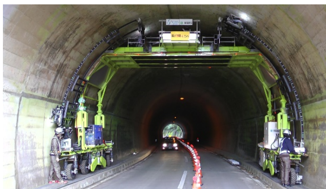
平沢トンネルにおける実証実験の様子
