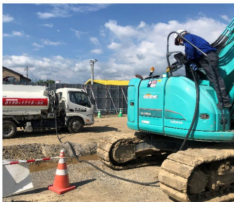
東海環状七崎高架橋他1橋(下部工)工事作業所
