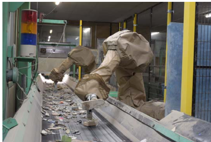
ベルトコンベアを流れる建設混合廃棄物から設定した品目のみ自動選別する
