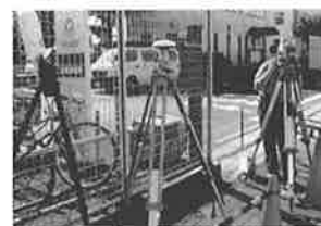
写真3 GPS, TS の設置
