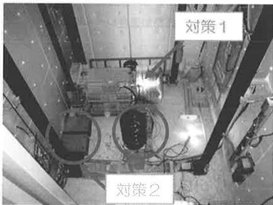
写真2 EV側対策状況
