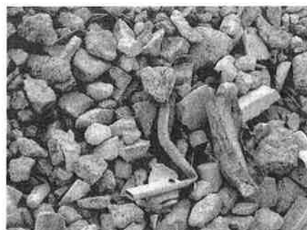
写真1 解体現場から搬出される廃棄物
