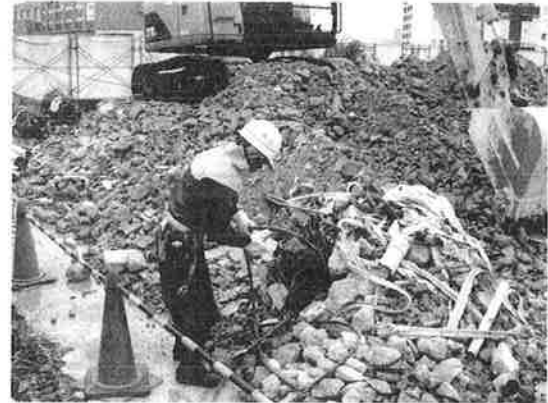
写真1 建築物解体現場における選別作業
