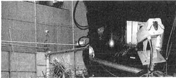
写真2 作業階カメラ（左）、搬出階カメラ（右）
