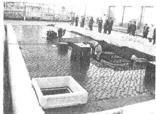
写真1 雨水貯留槽の施工状況
