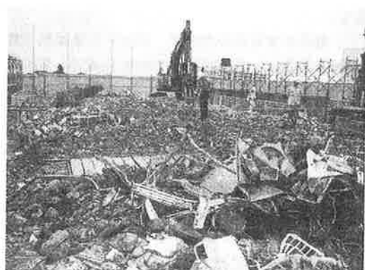
写真 1 解体時に発生する廃棄物
