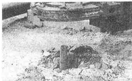
写真7 先端部分離後、鋼管ケーシング撤去
