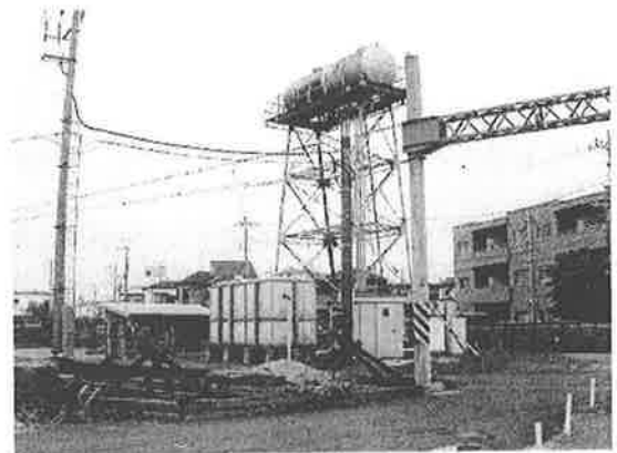
写真1 井水高置貯留タンク
