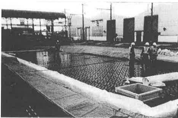
写真3 アクアトラップ雨水貯留槽施工状況
