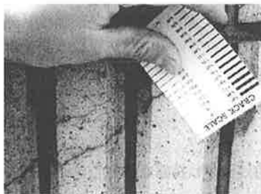
写真2 クラックスケールによるひび割れ判定
