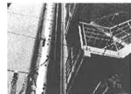
写真4 建物間の狭い作業スペース
