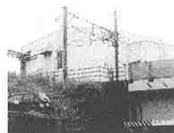
写真3 鉄道線路に面する壁面
