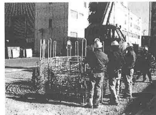
写真3 コイルスタンドへの盛替 (50mmピッチ)
