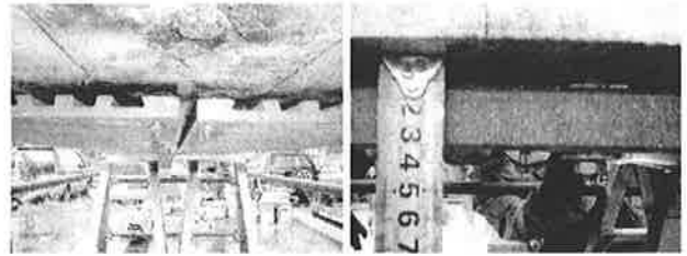
写真1 セメント板取付け状況
