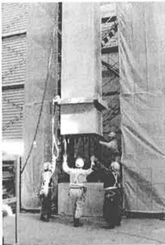
写真4 建て込み状況
