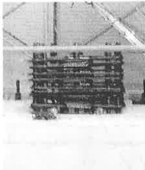
写真1 フーチング定着鉄筋
