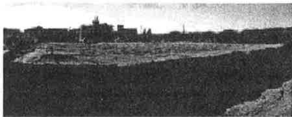
写真1 盛土の外観(実験フィールド全景)
