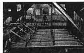
写真10 天井面の垂れ
