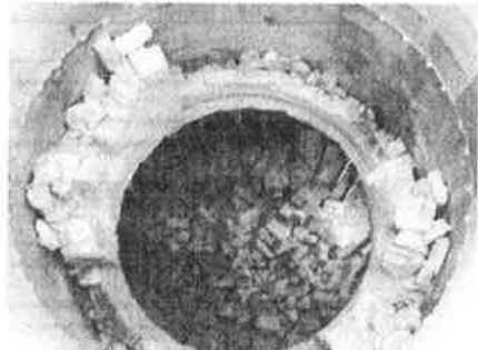
写真10 解体後状況（底部）
