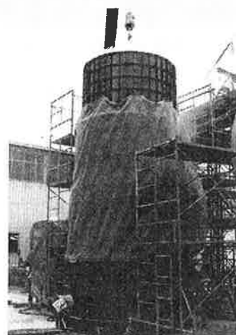
写真8 模擬煙突内壁レンガ解体状況
