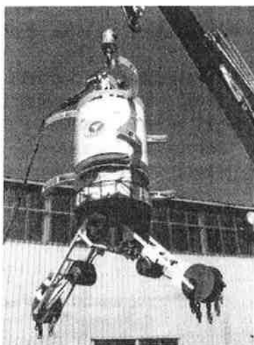
写真7 煙突内壁レンガ解体装置
