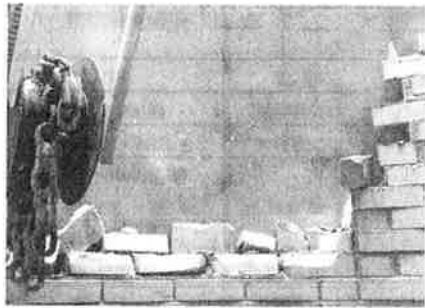
写真9 解体された内壁レンガ
