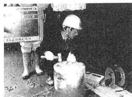
写真 3 杭の非破壊試験
