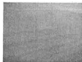
写真4 ケレン後状況
