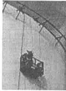
写真 18 乾燥膜厚測定
