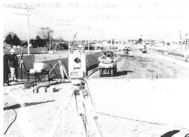
写真2 自動追尾トータルステーション追尾状況
