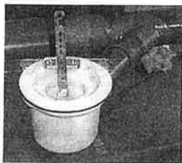
写真3 封水変位確認状況
