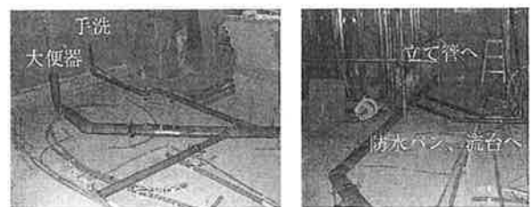
写真5 排水管設置状況
