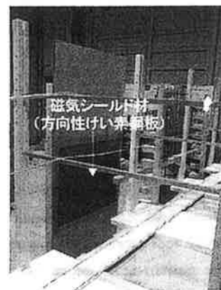
写真4 磁気シールド材設置状況
