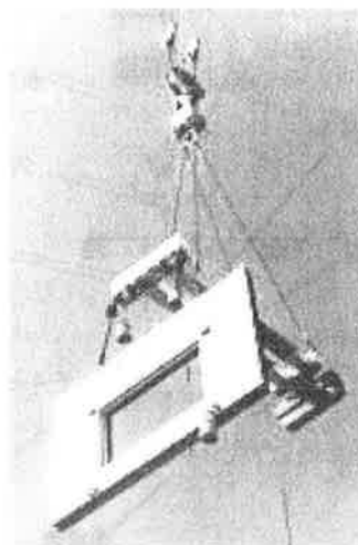
写真2 外壁板取付システム
