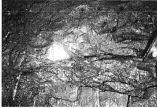
写真1 泥岩層内の破碎帯（開口巾が広い亀裂が目立つ）
