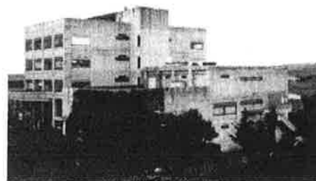
写真2 温度測定壁面の状況
