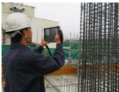
【配筋検査システム】
