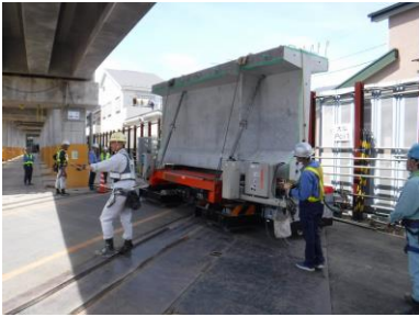
写真 7 : 現場一般道横断
