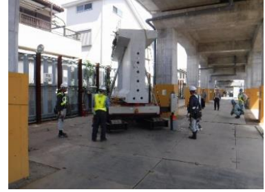
写真 6 : 現場カーブ区間
