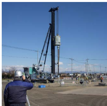
施工位置誘導実験状況
