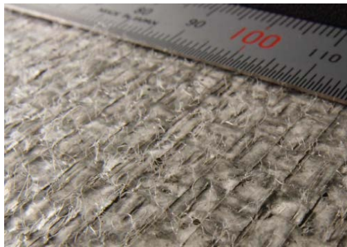
写真3 タイル張り前のコンクリート表面
