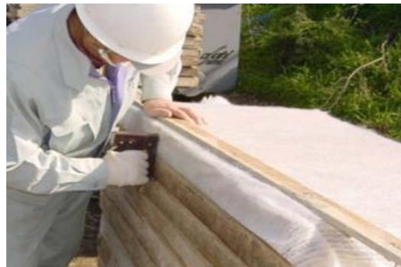
写真2 繊維植込みシート型枠貼付け
