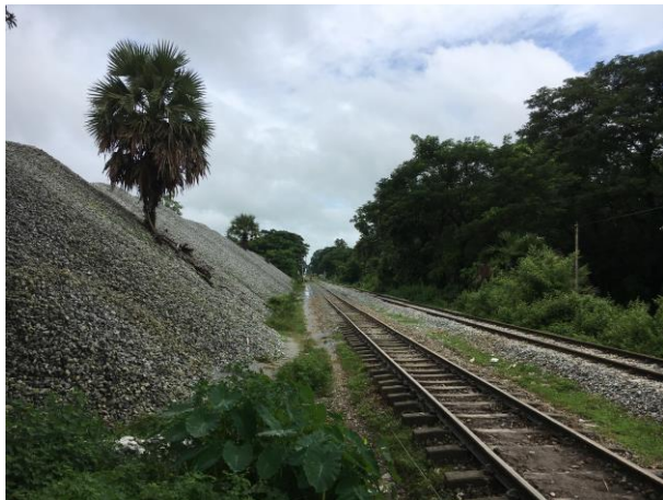
整備前の軌道
