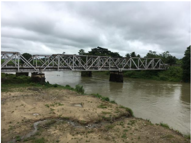
整備前の橋梁
