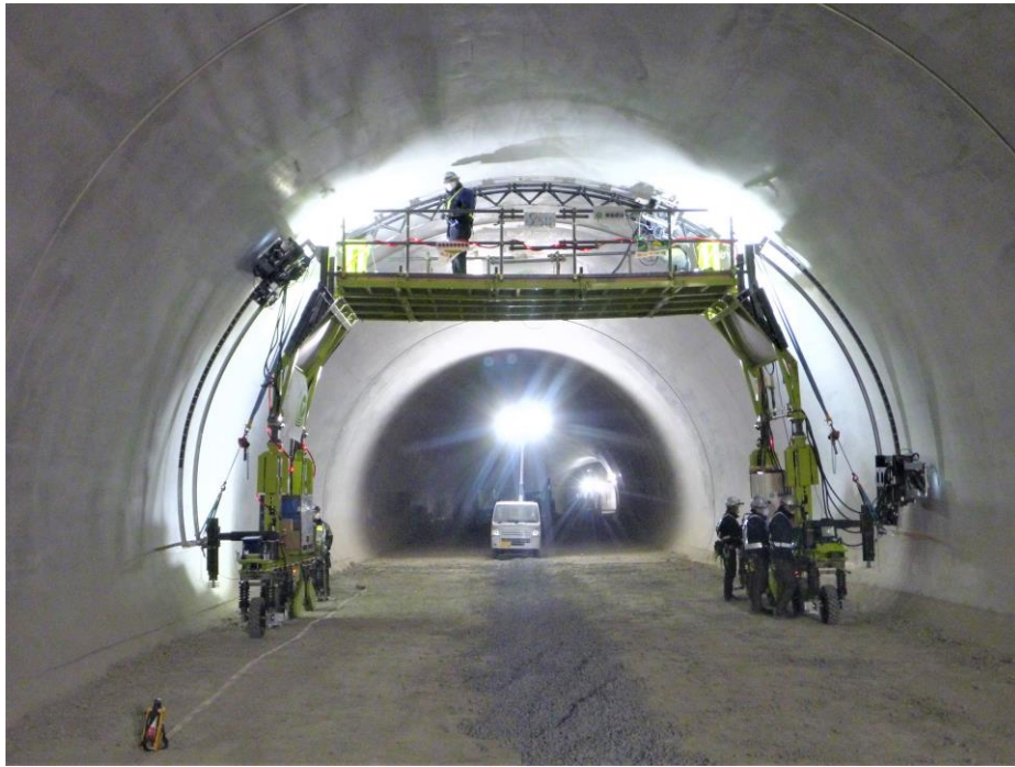
トンネル全断面点検システム
