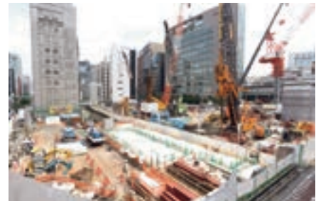
工事中の南街区の様子
