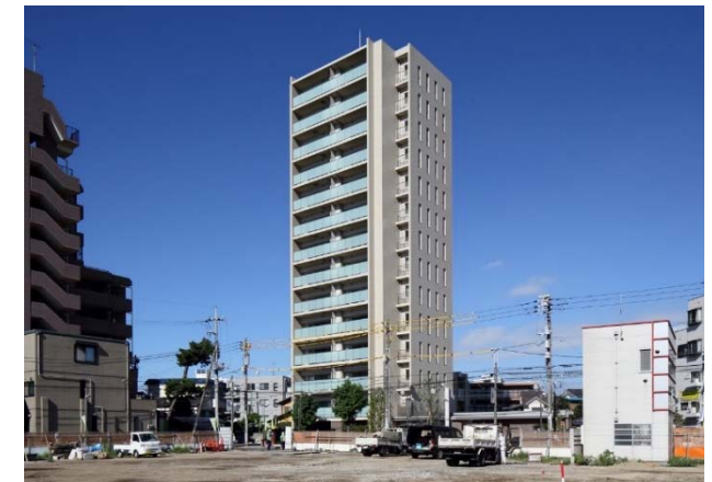
市川市真間一丁目計画新築工事
