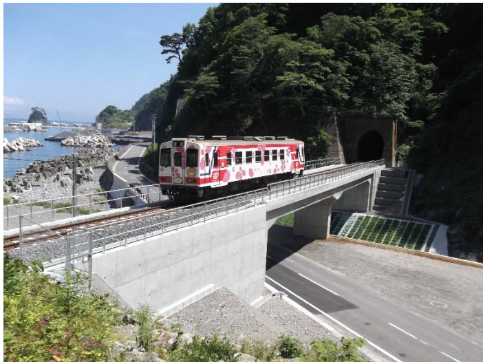
三陸鉄道北リアス線 小本・田野畑間災害復旧工事
