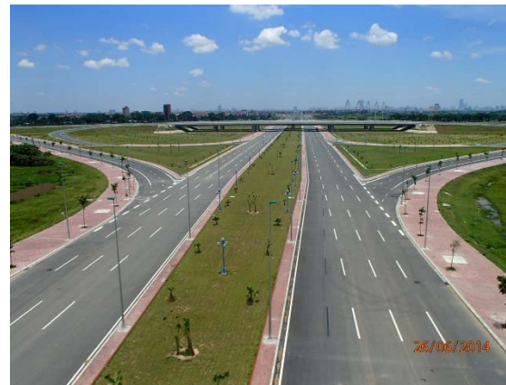
ニャッタン橋(日越友好橋)プロジェクト
