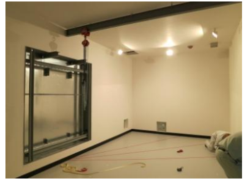
図3 小型電波暗室内観と試料取付開口
