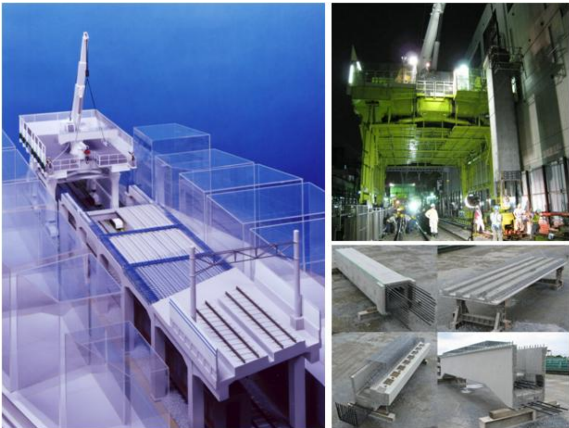
写真 京急蒲田駅付近連続立体交差事業における施工事例
