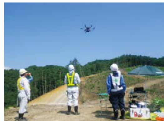
ICTを利用した測量の様子
